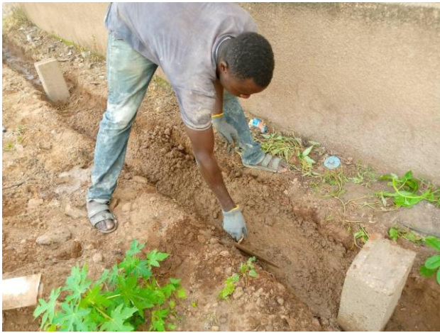
Aanleg van sleuf voor fundament van het bassin
