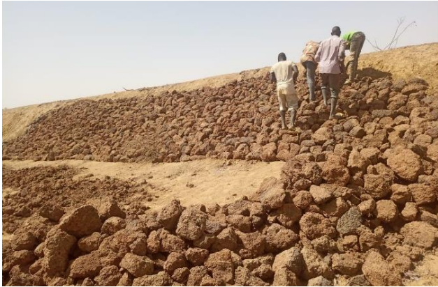
Ter bescherming van de dijk worden de taluds volledig bedekt met uitgehakte rotsblokken
