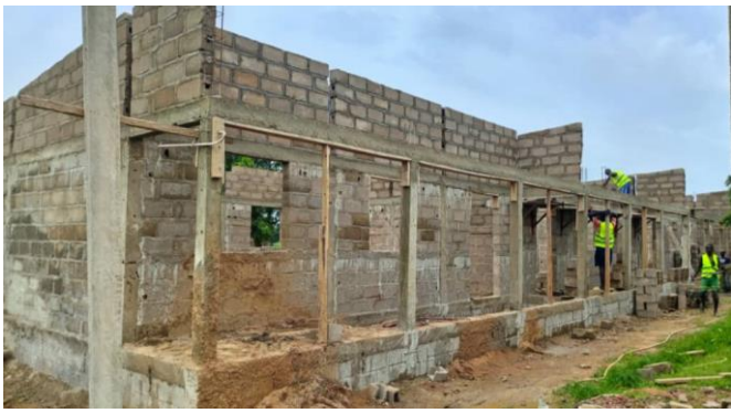
De ruwbouw van de school vordert gestaag
