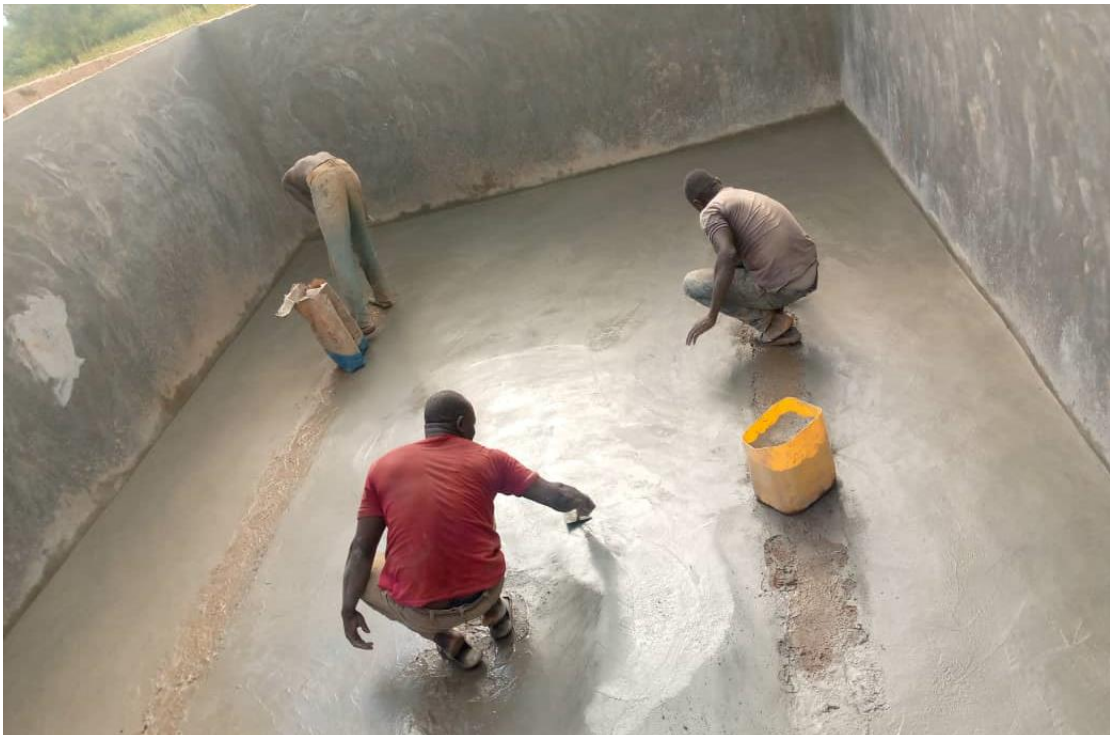
De afwerking in volle gang
